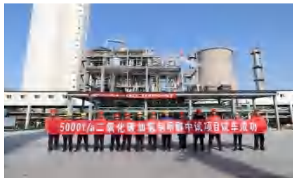
中试装置现场
